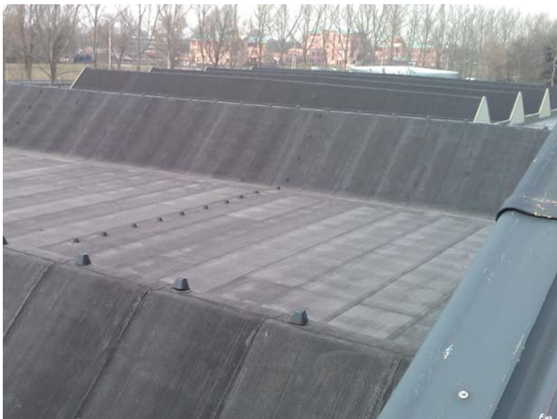
De medewerkers van Boersen Bliksembeveiliging zien het gemiddeld één keer per week, al het koper van het dak gestolen. Gemiddelde schade: 2500 euro.
